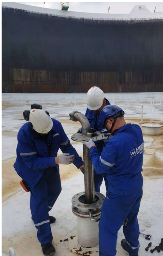
Montaż dyszy rozpylającej podczas prób technologicznych w zbiorniku magazynowym
