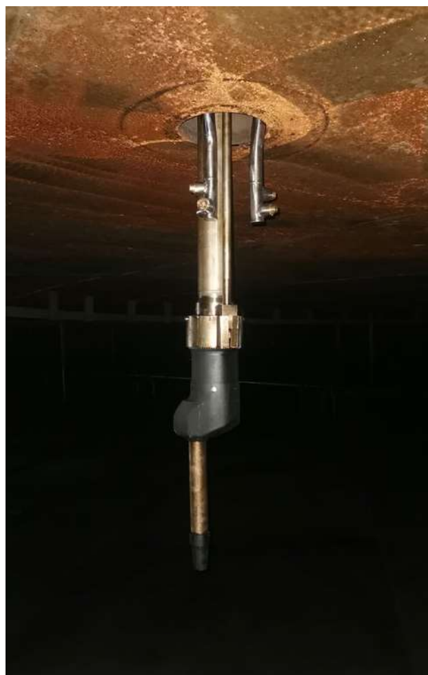
Montaż lancy z dyszą rozpylającą podczas prób technologicznych w zbiorniku magazynowym
